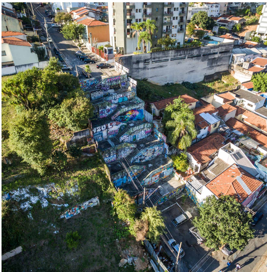
VISÃO AÉREA DA ESCADARIA DA RUA COTOXÓ ANTES DA REFORMA
