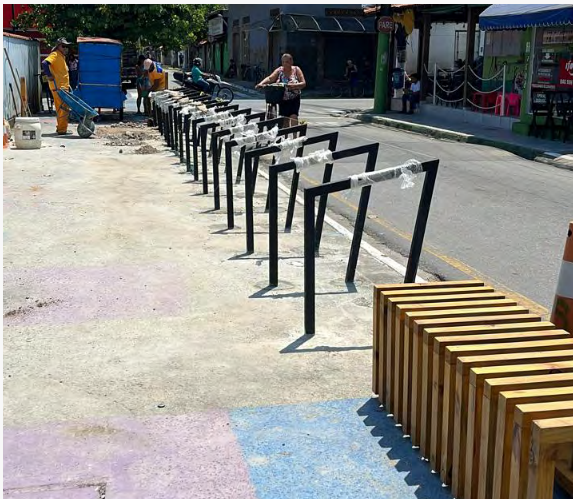
Novos paraciclos e banco sendo instalados em frente à Escola Municipal Frei Bernardo.
