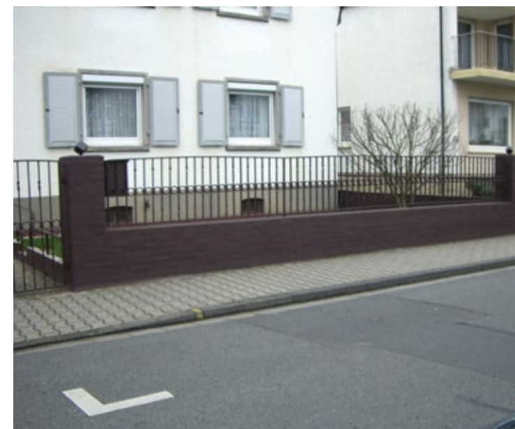
Falta de muros baixos diminui as possibilidades de brincar e descansar
